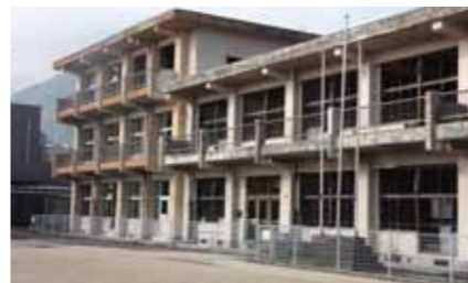
災害遺構として保存されている被災校舎
